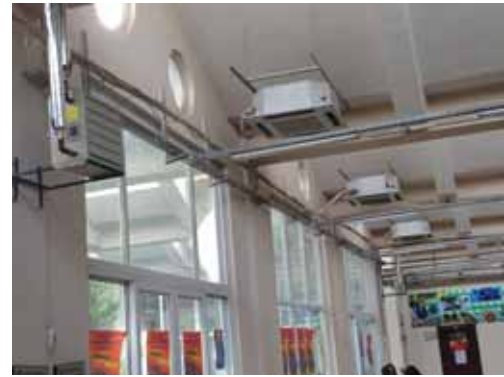
Sümerpark doğalgaz dönüşümü
