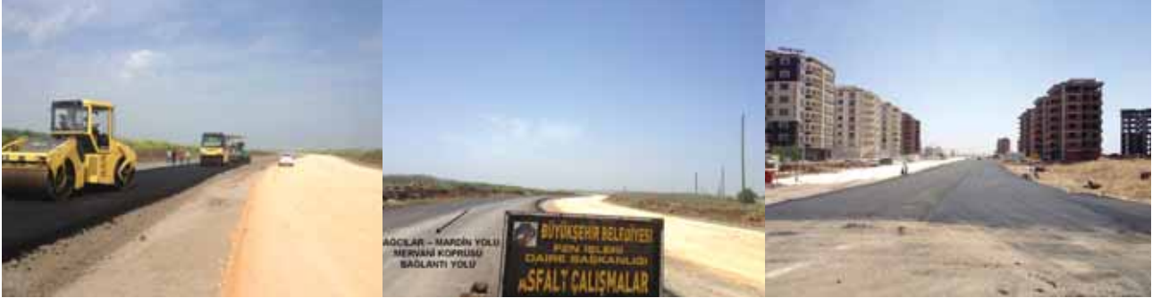
Bağcılar- Mardin Yolu- Bağivar Köprüsü bağlantı yolu
